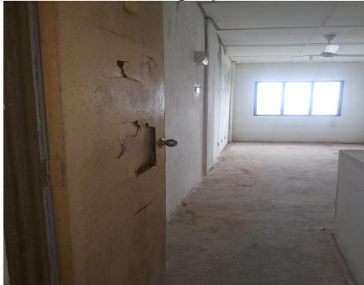
Gambar 1.3 Daun Pintu Rumah Di Tingkat 9, Blok B Yang Dipecahkan
