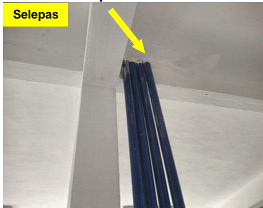
Gambar 2.10 Kesan Resapan Telah Dicat Baharu
