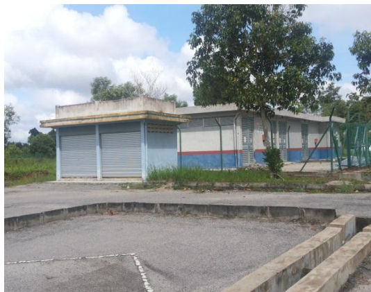
Gambar 1.14 Rumah Sampah Yang Dibina Bagi Penghuni Blok B Yang Tidak Digunakan
