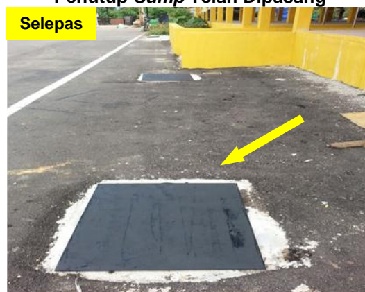
Gambar 2.6 Penutup Sump Telah Dipasang
