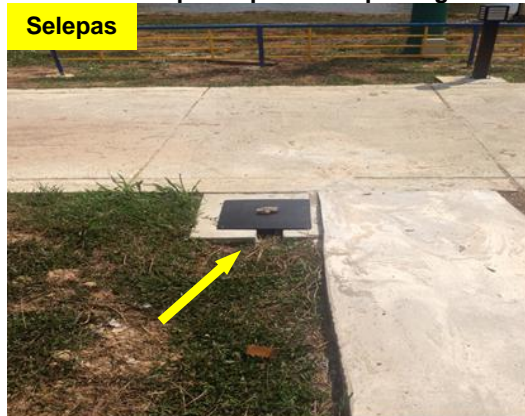
Gambar 2.8 Penutup Sump Telah Dipasang
