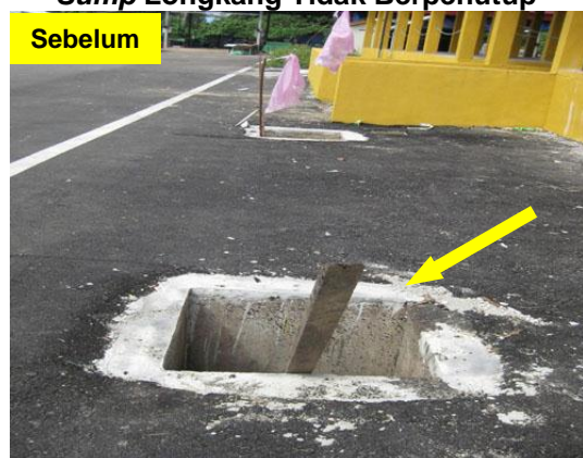
Gambar 2.5 Sump Longkang Tidak Berpenutup
