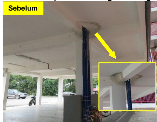
Gambar 2.9 Kesan Resapan Pada Siling Bumbung
